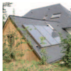
CES en surimposition de toiture inclinée
