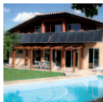
SSC en façade sur support incliné à 60° Photo : M. Flament
