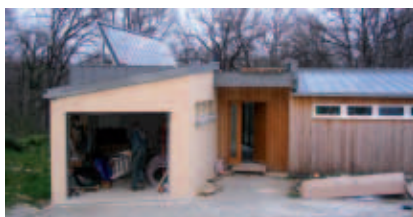
SSC en toiture terrasse sur bâtiment individuel Photo : Habitat Energies - 46
