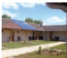
Ci-contre figure une autre installation validée par un ABF : il s'agit d'un hôtel restaurant dans le Parc Naturel Régional des Causses du Quercy. Les capteurs sont cette fois complètement incorporés dans l'épaisseur de la toiture.
