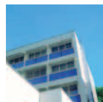
Capteurs thermiques en allège + photovoltaïque en brise soleil (Suisse) Photo : SSES Suisse © Gerber Beat, SSES Bern
