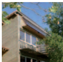
SSC en façade sur support incliné à 60° avec habillage Photo : Habitat Energies - 46
