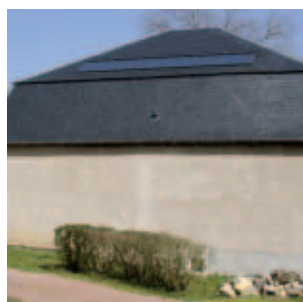
CES incorporé en toiture inclinée
