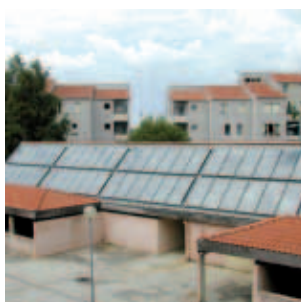
CES en surimposition de toiture inclinée
